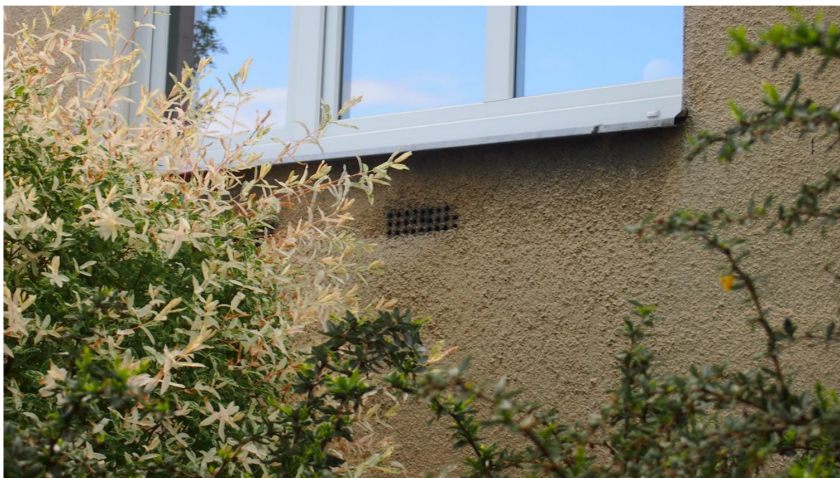
Rysunek 23 Zabezpieczone otwory wentylacyjne
